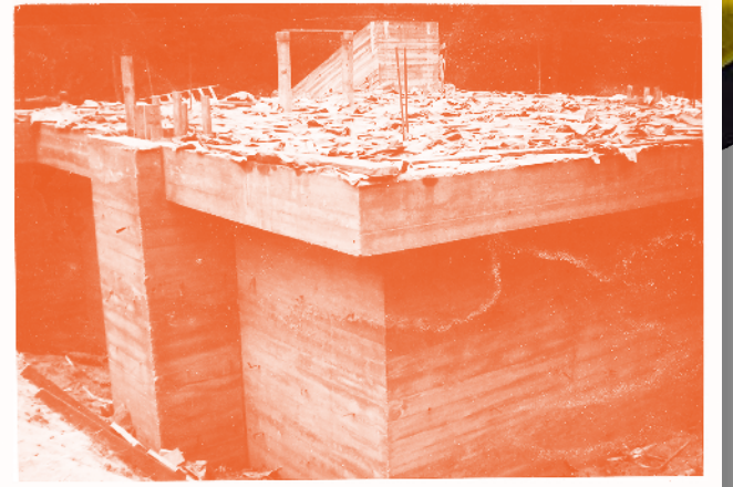
Betonggjutningen av ett skyddsrum är klart.
