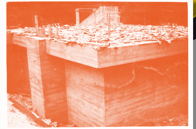
Betonggjutningen av ett skyddsrum är klart.
