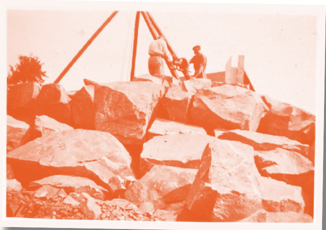
Stenpackning runt ett nybyggt skyddsrum.
