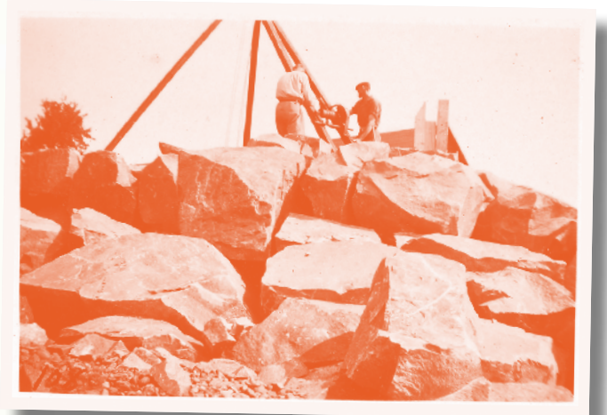
Stenpackning runt ett nybyggt skyddsrum.
