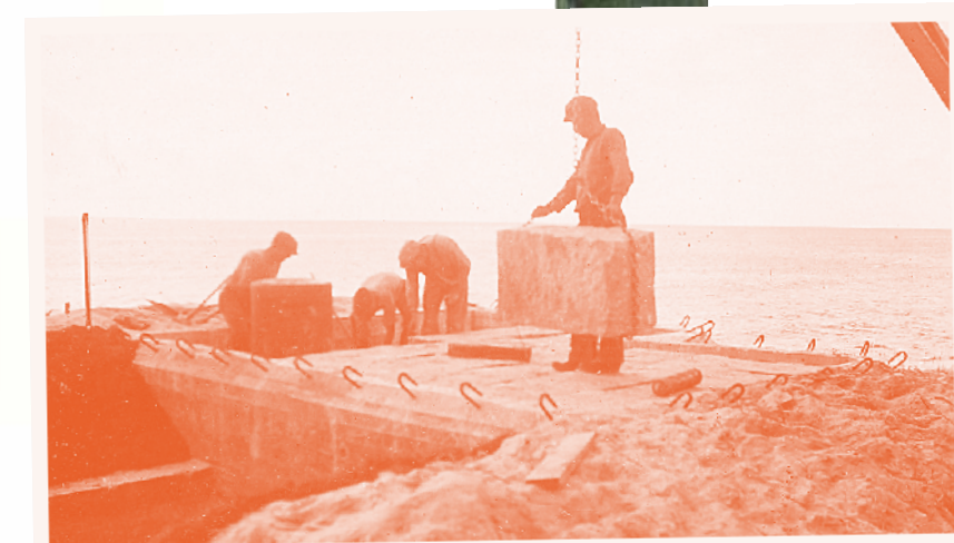
Förstärkningssten till bunkertaket.
